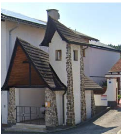
4. Oberdanegg - Oberdaneggerstraße 2/4. Der Defibrillator befindet sich an der Wand in der Kapelle.
