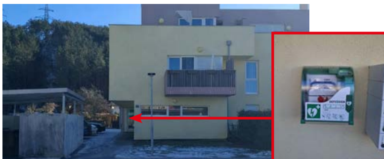
5. Wohnhausanlagen Paul-Kögler-Straße 4A - Der Defibrillator befindet sich beim Eingang zum Wohngebäude
